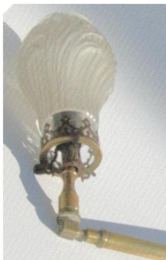
Applique d'éclairage au gaz. Bras en laiton orientable un mouvement. Bec droit « Auer » surmonté d'un verre dépoli.
